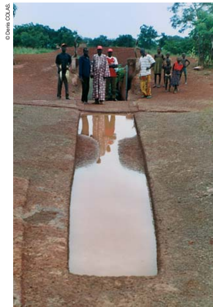
L'entrée de la grotte avec le canal d'alimentation en eaux de pluie.
