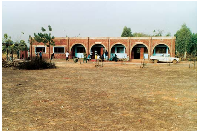
Le bâtiment des ateliers bois et fer. Sur la droite, la pauvre « Pigeot ».
